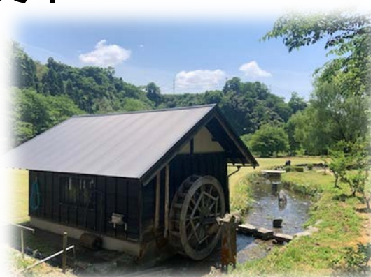
水から水車で電気と水素
